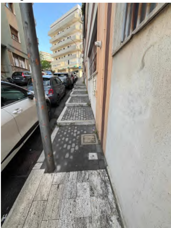
Gradonata su Via Nazario Sauro. Vista dall'ingresso
