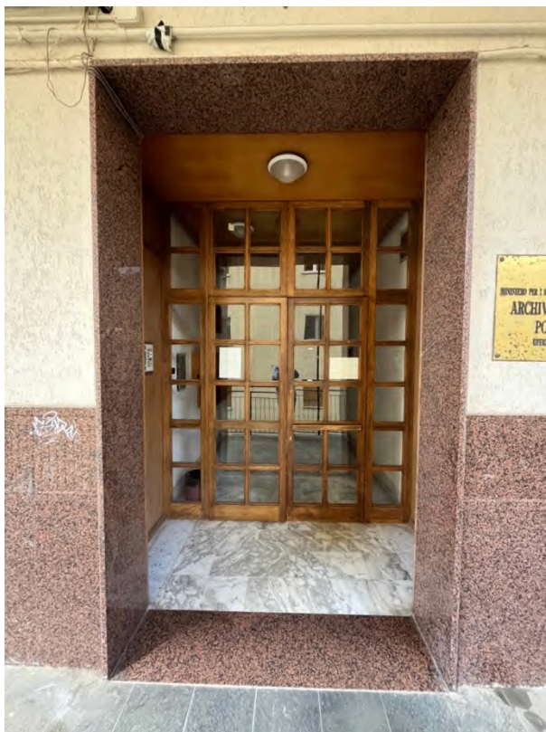
Ingresso su Terzo Livello
