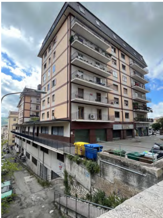
Terzo Livello. Ingresso su Viale Marconi da ballatoio.
