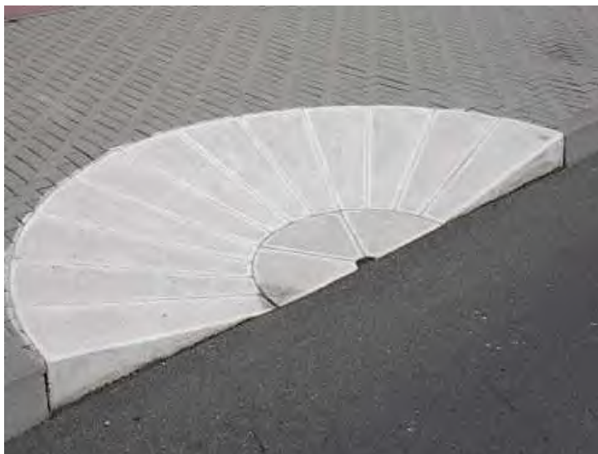
Realizzazione elementi di raccordo per eliminazione discontinuità altimetriche
