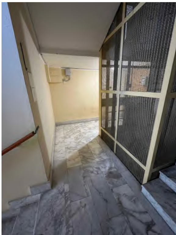
Terzo Livello. Vano Ascensore.
