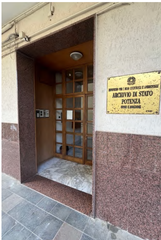
Ingresso su Terzo Livello
