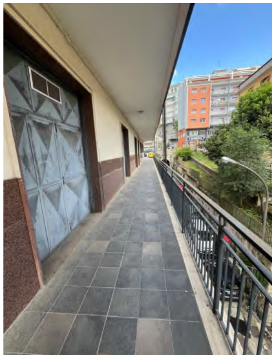
Terzo Livello. Ingresso su Viale Marconi da ballatoio.
